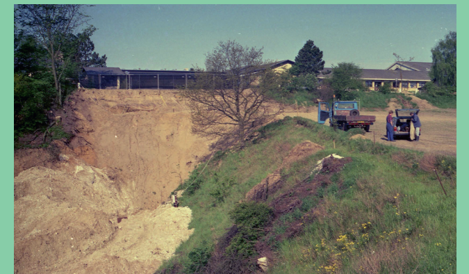
I 1989 skete der et større skred ved Mønsted Skole. En gammel minegang gav efter og efterlod et stort hul i jorden.
